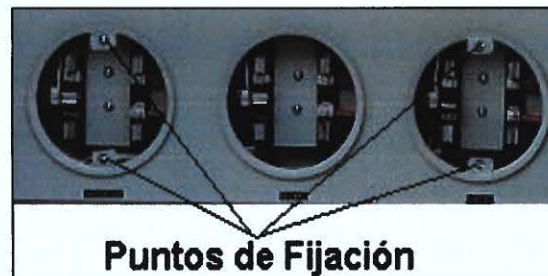
Figura 18: Fijación Láminas Cubre Falta
