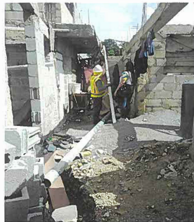
Apoyo a obra, VIME06
